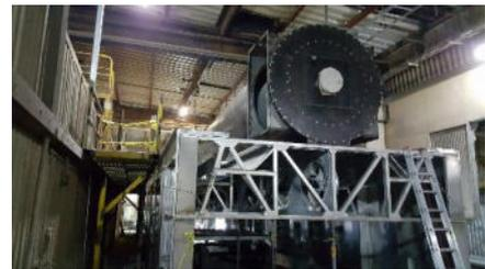
Zwischenzeitlich hatten wir die Decke und die Luftverteilungskanäle montiert. Auch mit der Isolierung und der Aussenverschalung konnten wir den hinteren Teil schon recht weit fertig stellen. Auf Wunsch des Kunden wurden mehrere Servicetüren eingebaut.
