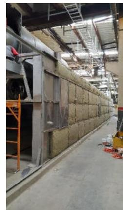
Von jetzt an konnten auch mehrere Arbeiten simultan ausgeführt werden. Im Innenbereich wurden alle Fugen silikonisiert, die Wände fertiggestellt und die entsprechenden Sensoren für Temperatur und Feuchte angebracht.
